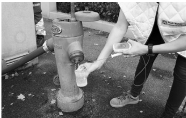
Qualitätskontrolle beim Spülen der Leitungen. (Bild: Wasserversorgung)
