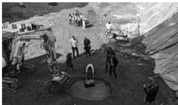
Neubau Schulhaus Schütze: Der Grundstein wird auf die Kassette gelegt. (Bild: Jacqueline Hehli, © KSP Limmattal)
