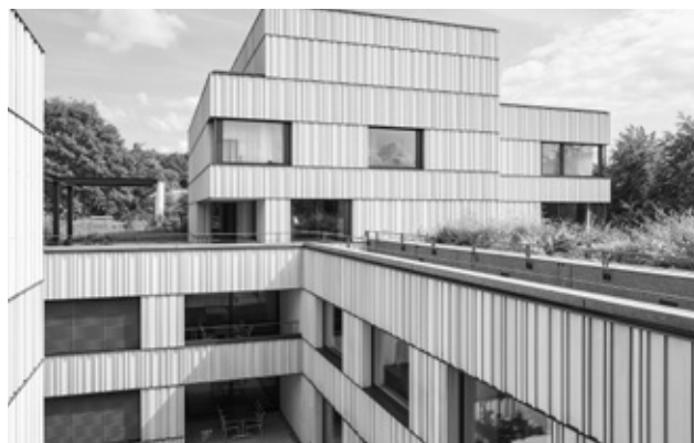
Haus B des Pflegezentrums Witikon nach der Instandsetzung. (Bild: Georg Aerni/Gäumann, Lüdi, Von der Ropp Architekten)
