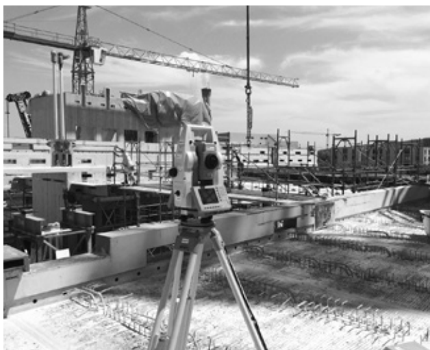
Vermessung auf der Baustelle Fernsehstudio Leutschenbach. (Bild: GeoZ)
