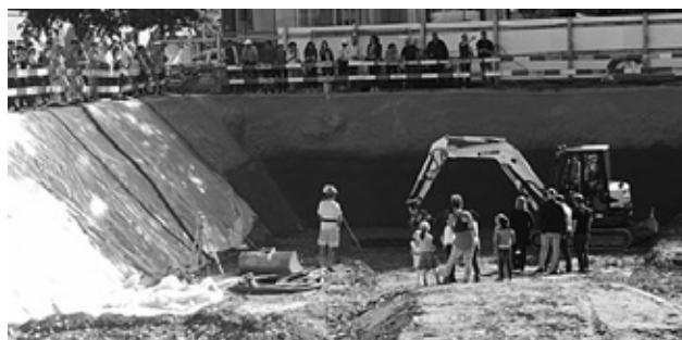
Kinder bestaunen den Bagger in der Baugrube des Schulhauses Schütze. (Bild: Jacqueline Hehli, © KSP Limmattal)
